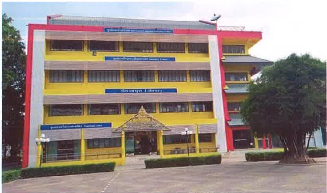
อาคารเฉลิมพระเกียรติ เป็นอาคารคอนกรีตเสริมเหล็ก 4 ชั้น มีพื้นที่ 1,088 ตารางเมตร ก่อสร้างเมื่อปีงบประมาณ 2548-2549 งบประมาณ 7,740,000 บาท
